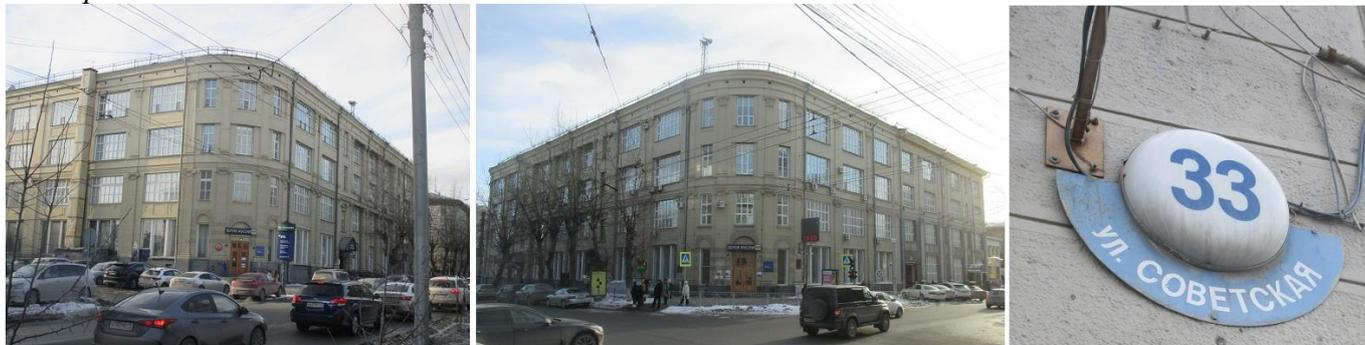
В 1927 году здание было реконструировано, надстроены два этажа, а помещения приспособлены под Главпочтамт. Позже, в 1968 году, здание было достроено до замкнутого прямоугольника с внутренним двором. Под зданием расположен подвал. Фундамент ленточный бутовый, наружные стены и цоколь кирпичные оштукатуренные, перекрытия железобетонные. Крыша стропильная, кровля металлическая. Крепкое получилось строение.
