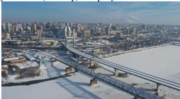
И все-таки строительство моста продолжается. К концу февраля на правом берегу завершают строительство последнего из трех автомобильных съездов. *Здесь установили подпорные стены, выполнили работы по гидроизоляции бетонных поверхностей и установили парапетное ограждение. Часть работ возобновят с наступлением тепла, а ввести в эксплуатацию съезд планируют в конце лета. Пока на 114-метровом пилоне выполняется*
