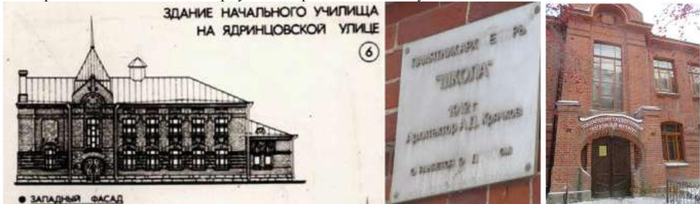
Здание имеет сложную, близкую к П-образной, конфигурацию в плане. Стены кирпичные, нештукатуренные. Крыша основного объема трехскатная. Под частью здания имеется подвал. Со стороны южного фасада к основному двухэтажному объему примыкает одноэтажная пристройка, предназначавшаяся для квартиры заведующего училищем (<http://nsk.novosibdom.ru/node/2192>).
