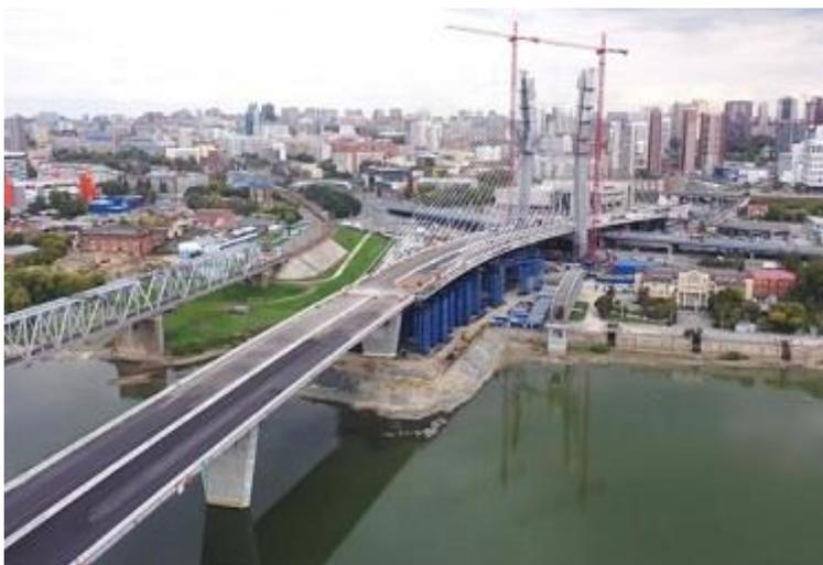
Конструкция четвертого моста через Обь в виде буквы “Н” станет жемчужно-белой после многослойной покраски. Сейчас ведется финишная покраска конструкций, она выполнена на 20%: 2000 квадратных метров из 10000. Пилоны моста красят 8 промышленных альпинистов. Техническую готовность мостового перехода специалисты оценивают в 90% (<https://ngs.ru/text/gorod/2023/09/25/72742412/>).
